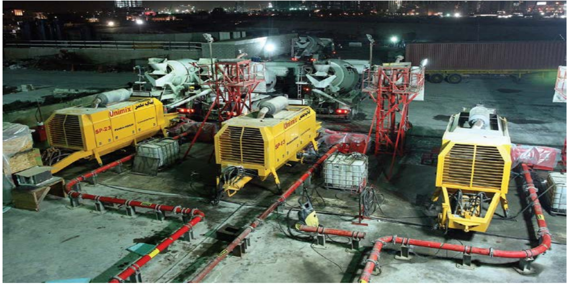
صورة رقم (5-10) توضح المضخات المستخدمة أثناء صب برج دبي
