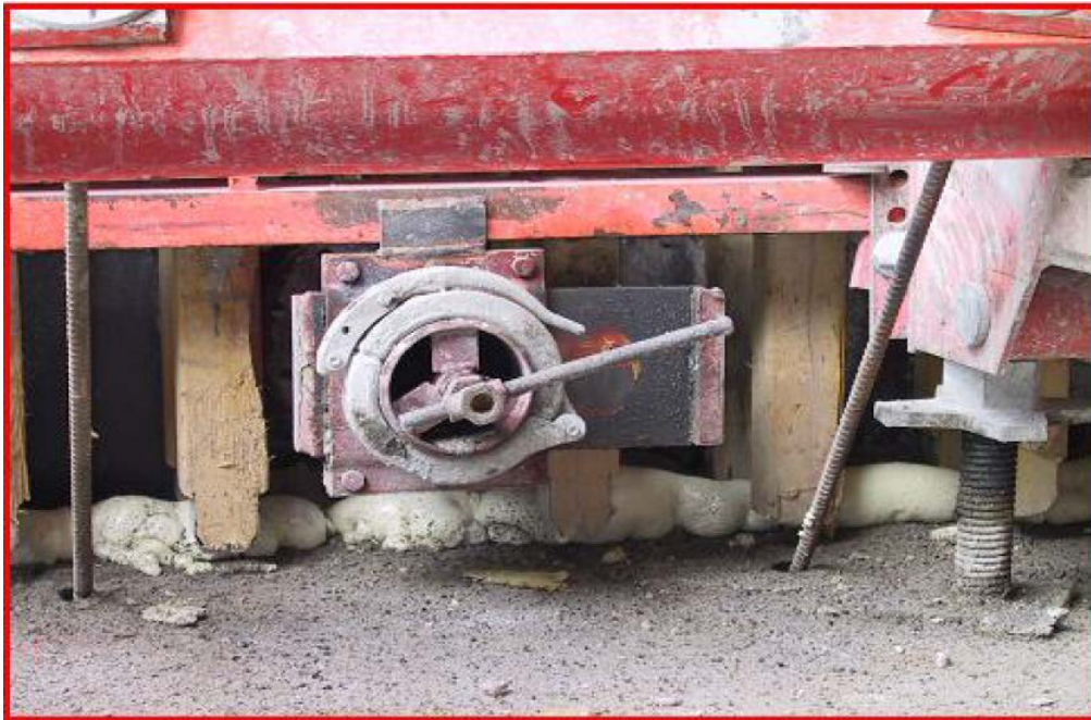
صورة رقم (5-6) الفتحة التي تم صب البيتون ذاتي التوضع منها بعد إغلاقها
